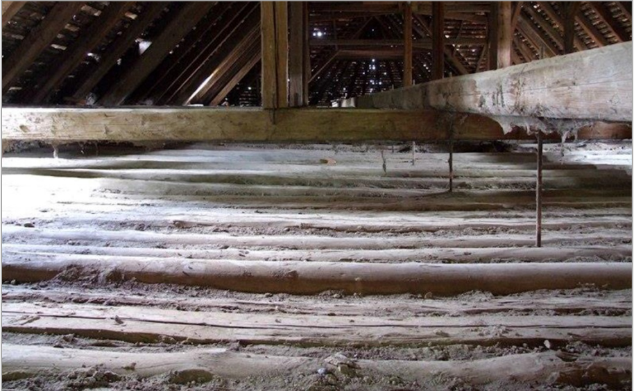
Kirchendecke, nach der Entfernung der Deckschicht
