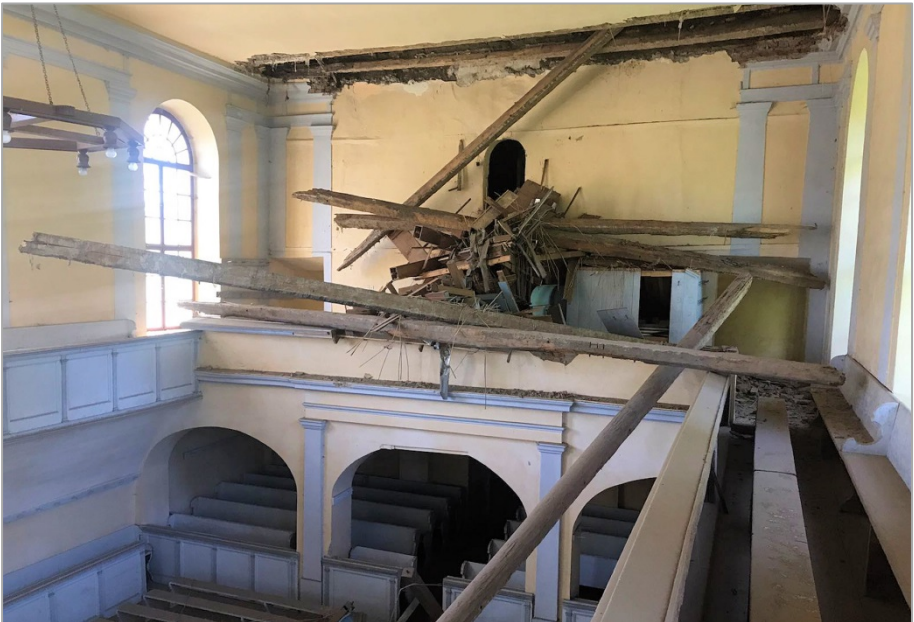
Eingestürzte Deckenbalken
