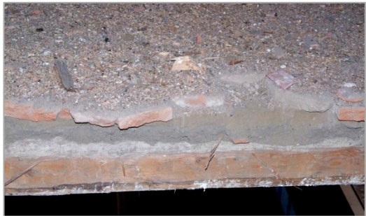
Querschnitt durch die Nadescher Kirchendecke: Oberhalb des Balkens sieht man die Deckschichten aus Lehm, Ziegeln und Sand-Schrotgemisch Foto: M. Ferenc
