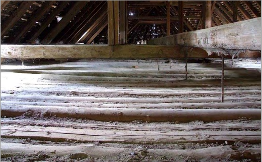
Kirchendecke, nach der Entfernung der Deckschicht
