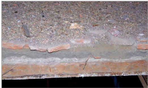
Querschnitt durch die Nadescher Kirchendecke: Oberhalb des Balkens sieht man die Deckschichten aus Lehm, Ziegeln und Sand-Schrotgemisch Foto: M. Ferenc
