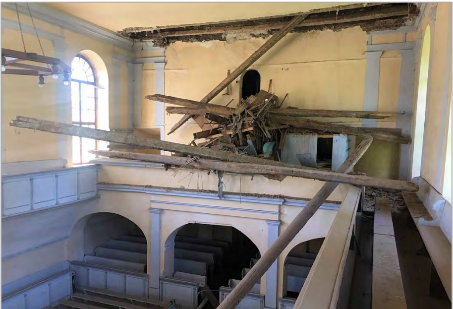
Eingestürzte Deckenbalken
