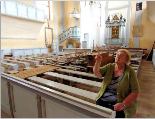
Die Kuratorin Eiwen zeigt entsetzt auf die Einsturzstelle Foto: Sigrid-Römer Eisele
