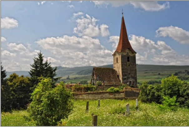
Felldorf im Jahr 2011 (oben) und nach der Teilrenovierung im Jahr 2016 (unten).
