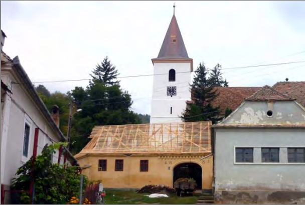
Der neue Dachstuhl am 13. September 2013 Foto: Johann Baier
