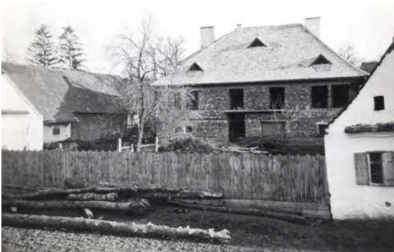
Neues Ungar-Haus im Rohbau
